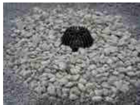
12. Засыпать гравием остальную поверхность кровли
