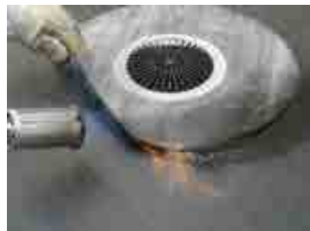
3. Приварить полимербитумное полотно воронки
