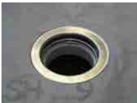
10. Зажать фильтрующий слой фиксирующим фланцем элемента HL350.0
