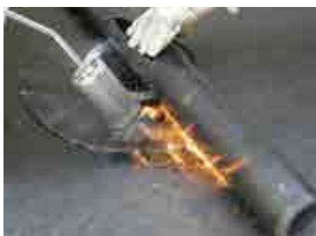
4. Наклеить 2-й слой гидроизоляции (до обжимного фланца)
