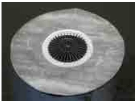
2. Закрепить корпус воронки HL62H
