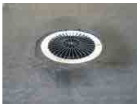
5. Так должна выглядеть воронка после укладки гидроизоляции
