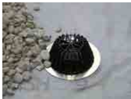
11. Установить листоуловитель, выполнить засыпку гравием (фракция: 20÷40 мм)
